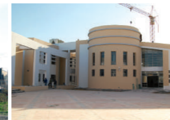
LYCEE HAMMAM SOUSSE Isolation du bâtiment avec ISOCOQ
