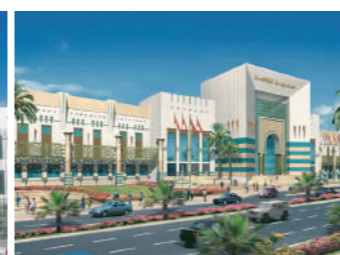
CITE DE LA CULTURE (Tunis) Isolation du bâtiment avec ISOCOQ
