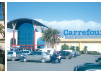
CARREFOUR (La Soukra) Isolation de la toiture avec ISOCOQ
