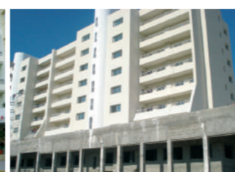
CITY CENTRE (Tunis) Isolation du bâtiment avec ISOCOQ
