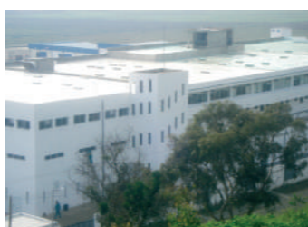
LAB. PHARMACEUTIQUE OPALIA (Kâlaat El Andalous) Isolation du bâtiment avec ISOCOQ
