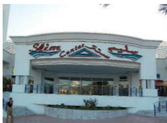
SLIM CENTRE (Sousse) Isolation de la toiture avec ISOCOQ
