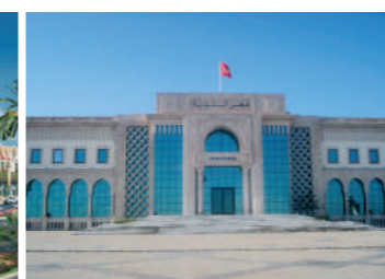
HOTEL DE VILLE (Tunis) Isolation du bâtiment avec ISOCOQ
