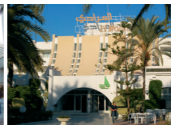
HOTEL EL MOURADI (Sousse) Isolation de la toiture avec ISOCOQ
