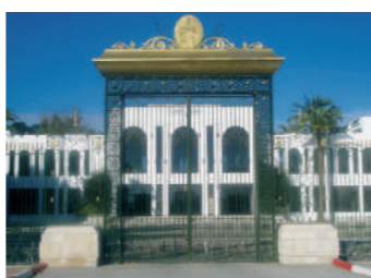
ASSEMBLEE NATIONALE ( Bardo ) Isolation de la toiture avec ISOCOQ
