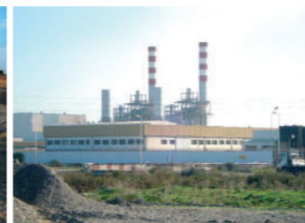
STEG (Radès) Isolation du bâtiment avec ISOCOQ
