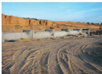
BARRAGE CHAFFAR (Sfax) Fond de joint avec ISOCOQ haute densité
